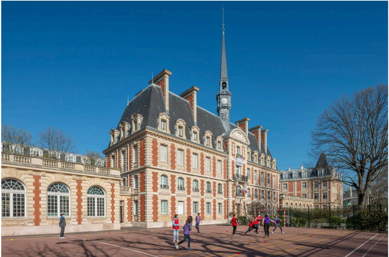
Le lycée Pasteur de Neuilly-sur-Seine est le dernier entrepris avant la Première Guerre mondiale, en 1912. L'architecte Gustave Umbdenstock dissimule une structure intégralement en béton armé derrière des façades traitées à la manière de la grande architecture classique française – pierre, brique et ardoise évoquant ici le style Louis XIII.
