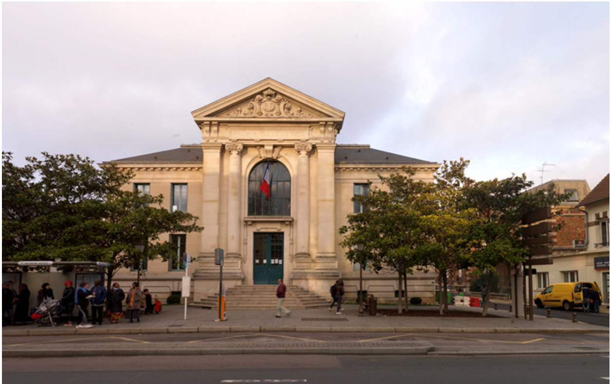
Vue de la façade.
