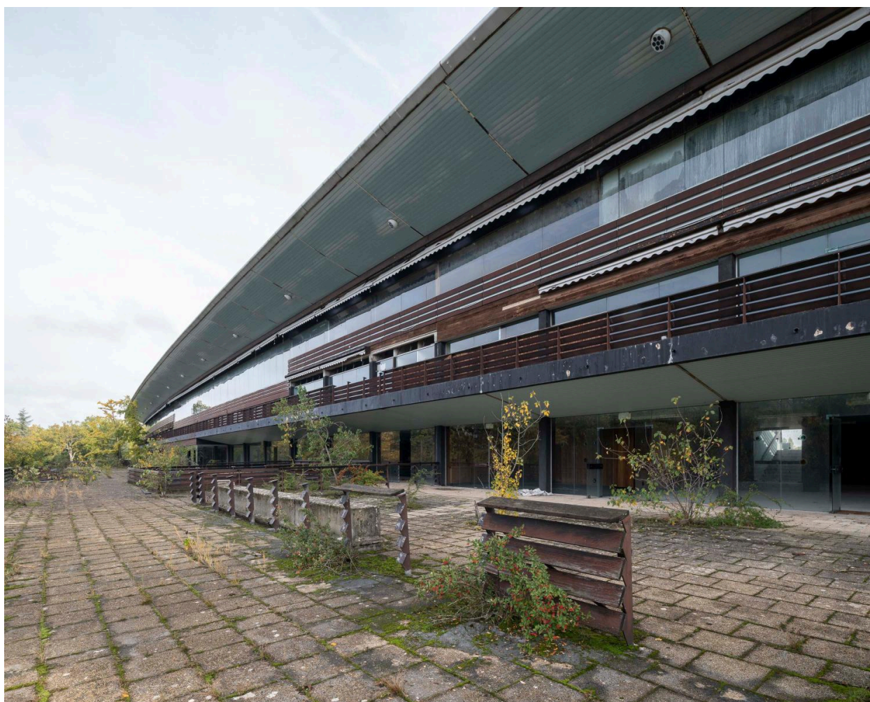
Façade postérieure de la tribune, avec les ouvertures en bandeaux vitrés du restaurant panoramique donnant sur le rond de présentation.
