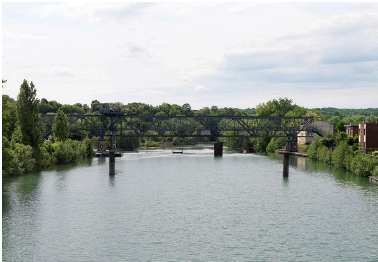
Vue d'ensemble, depuis l'amont.
