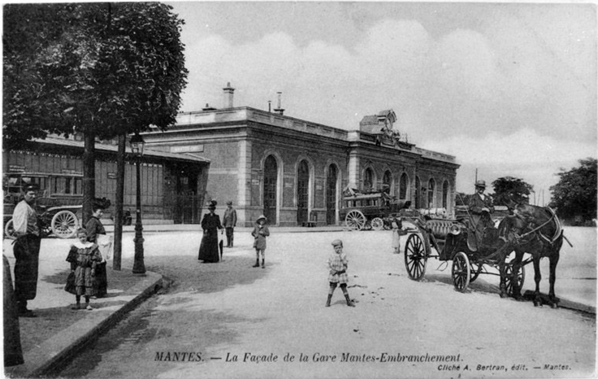
Vue de la gare construite en 1892. Carte postale (Région Ile-de-France. Fonds CREDOP)
