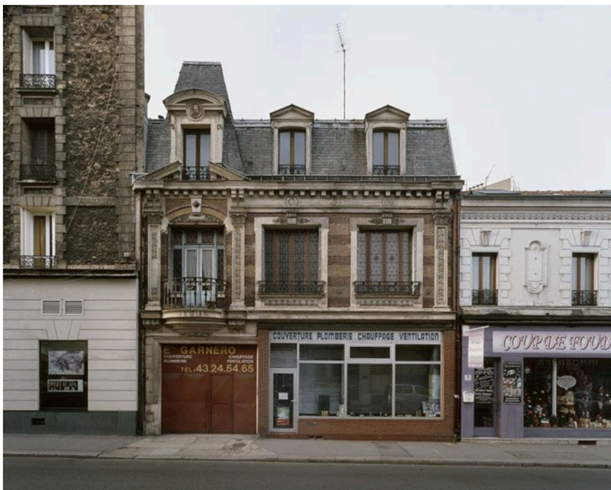
Vue d'ensemble de la maison de l'architecte municipal Mathieu, 3 avenue Ledru-Rollin.
