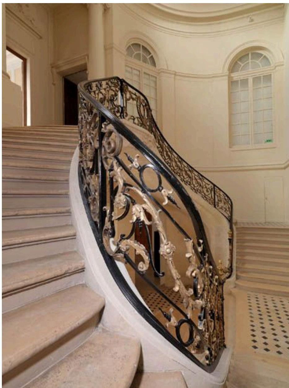
Détail de la ferronnerie.
