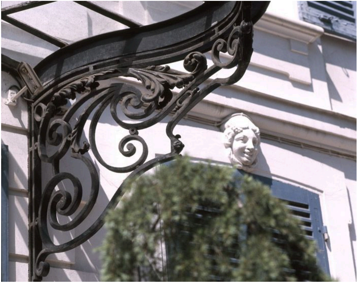
Détail de la console en ferronnerie supportant la marquise de la porte d'entrée.
