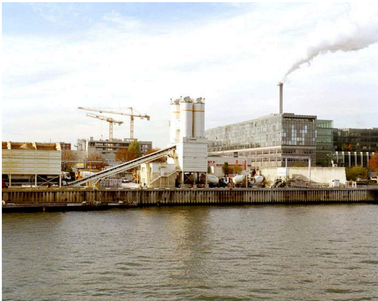
Ivry-sur-Seine. Vue rapprochée d'un quai de chargement.
