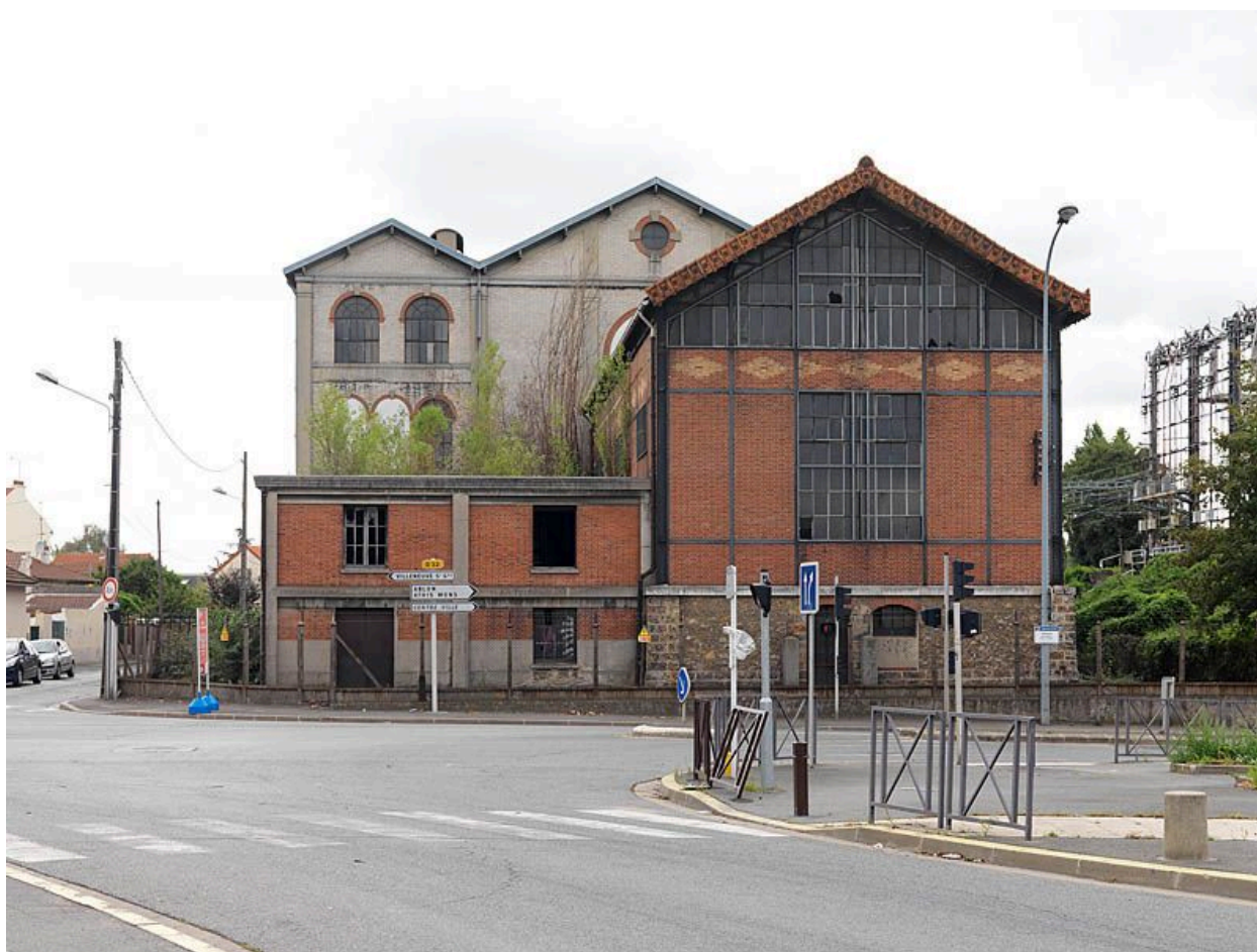
Villeneuve-le-Roi, transformateur, sous-station électrique dite de la Plaine, 1 rue du Colonel-Pierre-Brossolette. Elévation nord.
