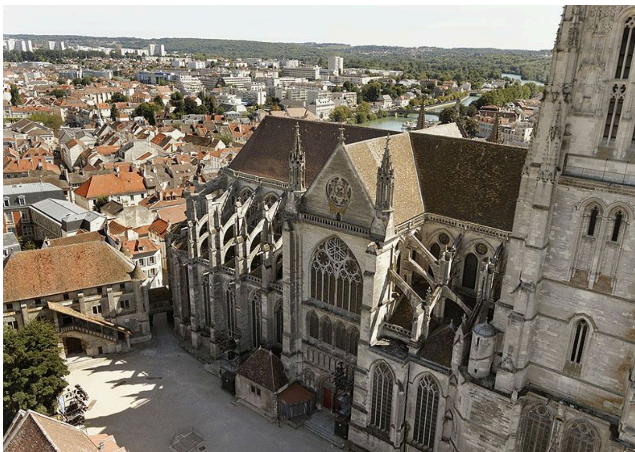
Vue panoramique, prise depuis un ballon captif : élévation nord.
