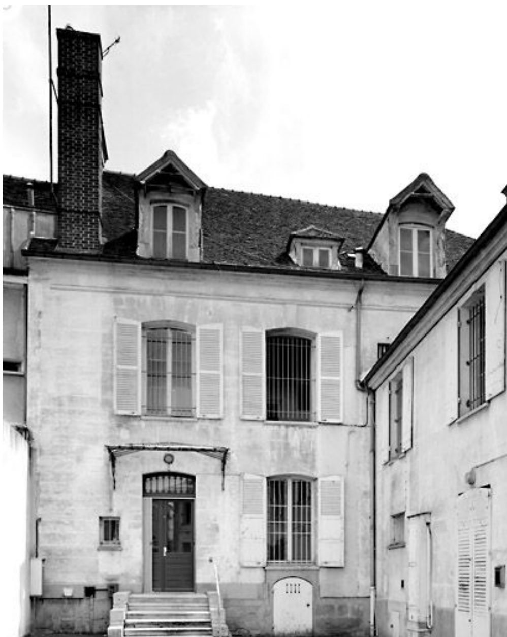
Façade sur cour.
