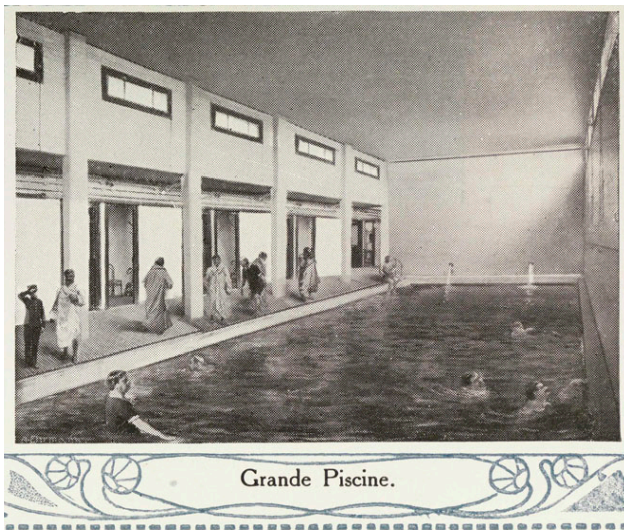
Vue intérieure de la grande piscine. Photographie, 1er quart 20e siècle. (AD Val d'Oise, D1877)
