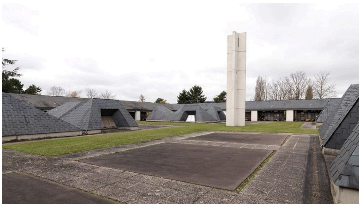
Vue d'ensemble de l'espace du colombarium et des fosses de l'ossuaire.
