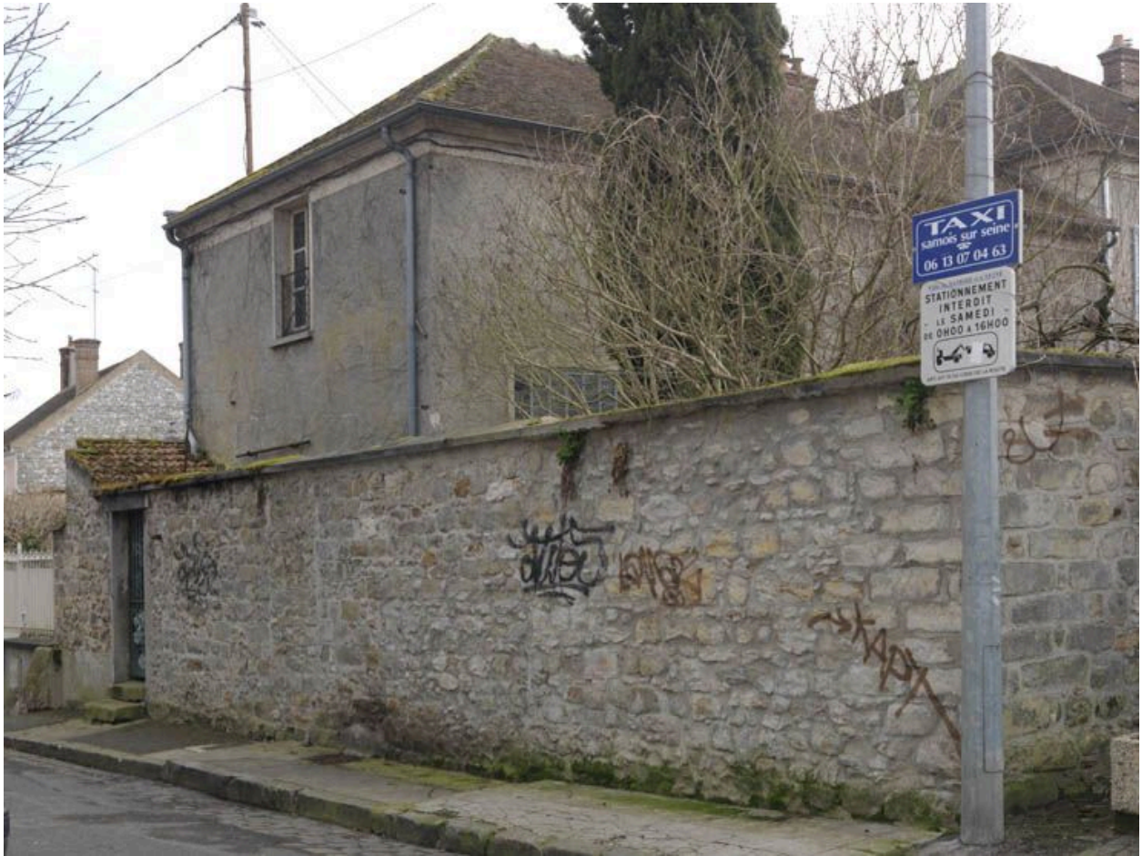
Mur de clôture et mur pignon de l'atelier de serrurerie.
