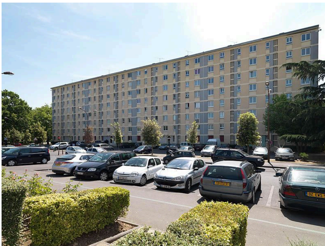
cité dite Résidence Les Fées. Façade arrière de la barre R+7.
