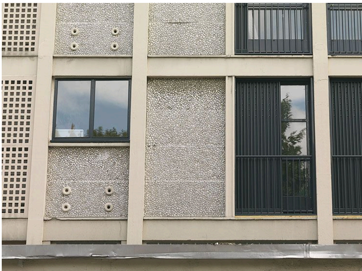
Détail de la façade après travaux.
