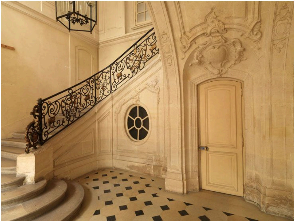
Vue d'ensemble de l'escalier depuis le vestibule : la voûte de l'escalier et l'agrafe rocaille de la porte.
