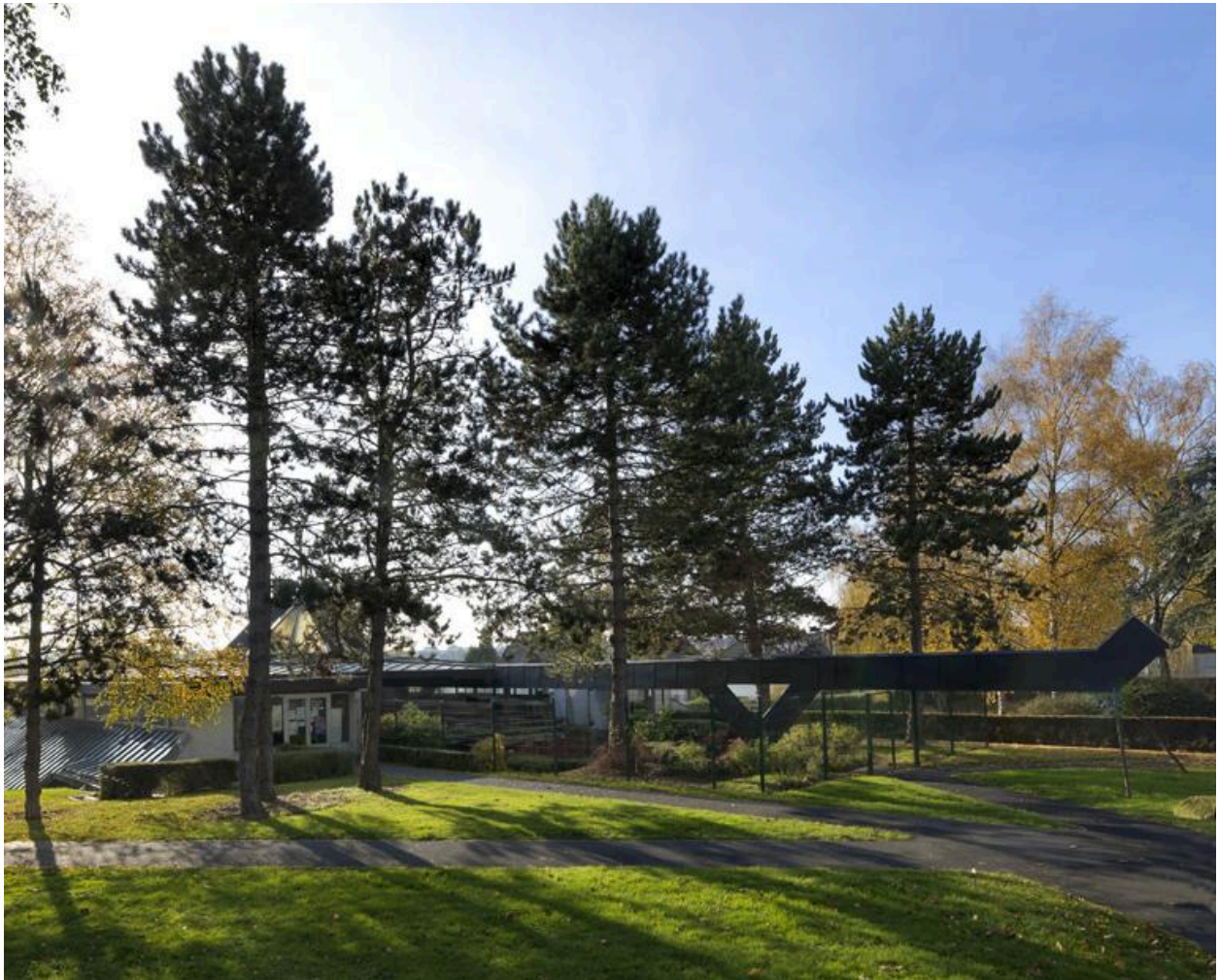
Vue de situation, depuis le nord-est.
