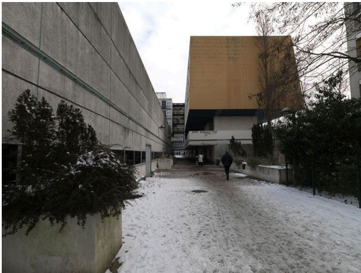
Vue de l'un des murs pignons de la piscine depuis l'allée de l'Arcade.
