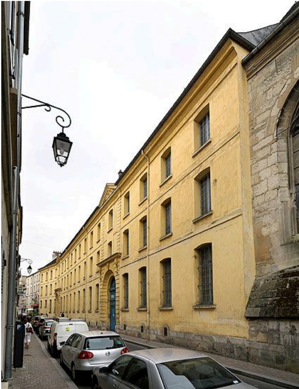
Vue d'ensemble de la façade sur la rue Saint-Remy, depuis le nord-ouest.
