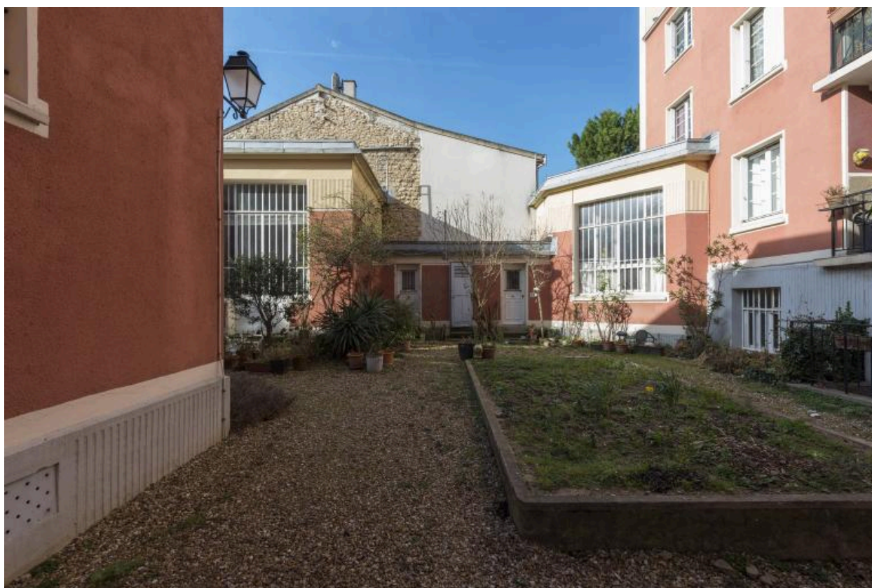
Vue des ateliers situés au rez-de-chaussée (1)
