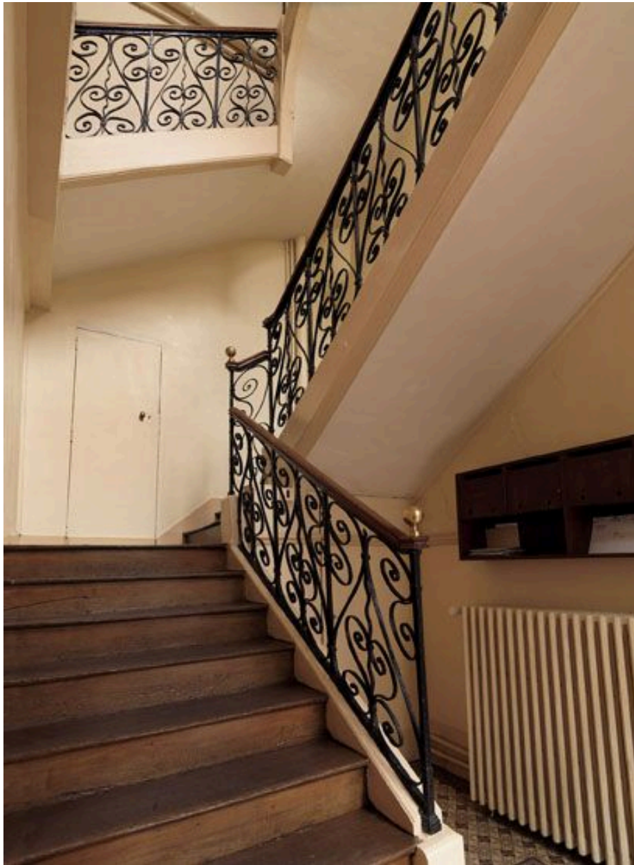
Vue intérieure : le départ de l'escalier avec sa rampe en fer forgé.
