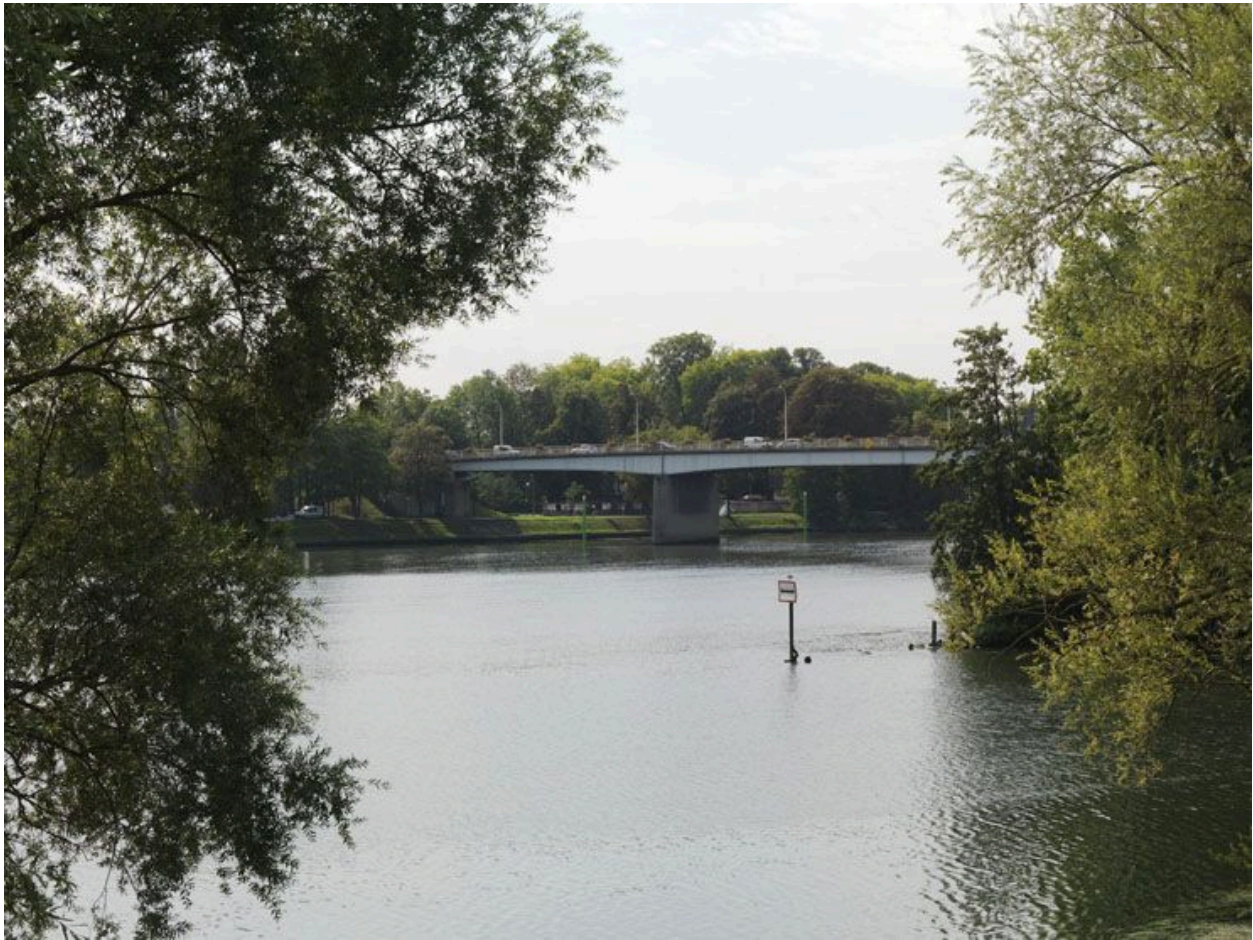
Meulan : vue du pont Rhin et Danube depuis les quais de l'Ile du Fort, à l'emplacement des vestiges du Grand Pont (détruit en 1944).
