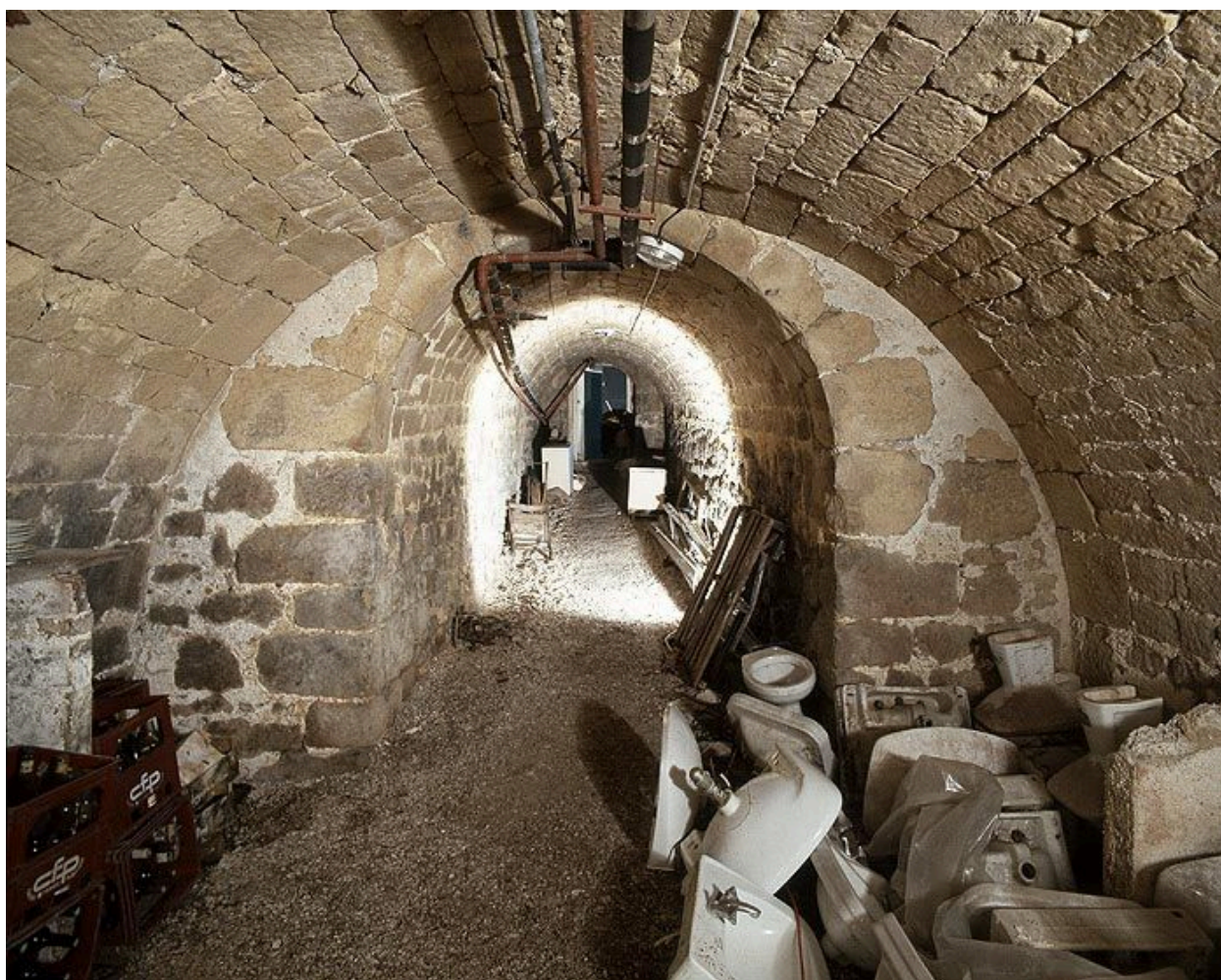
Vue du cellier en direction de l'entrée.
