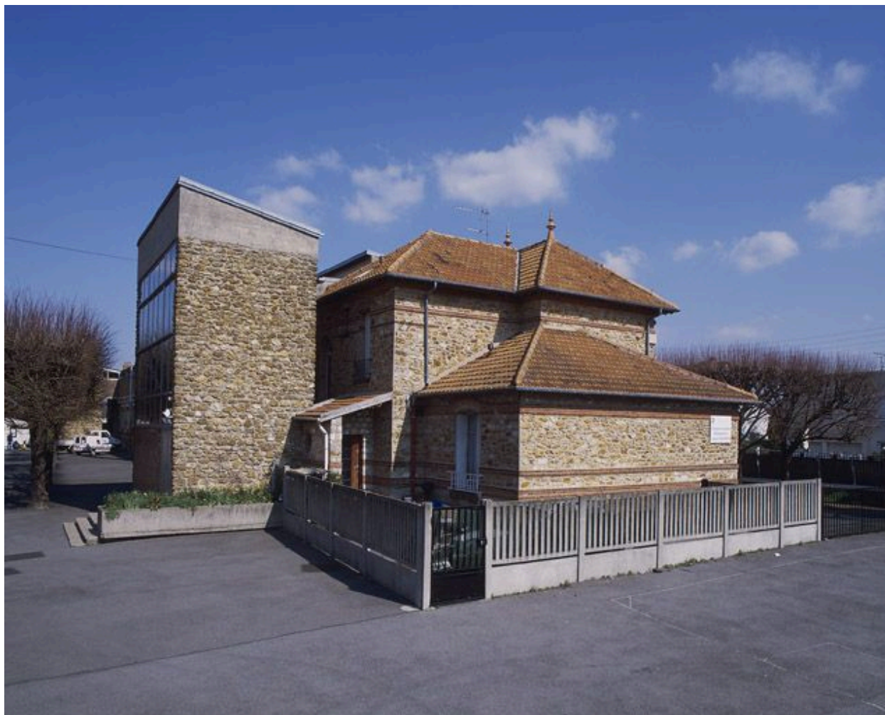
Vue latérale ouest.
