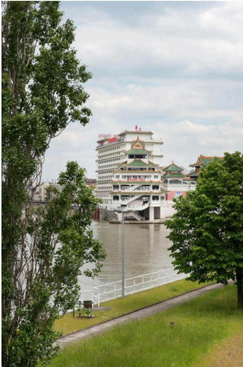
Vue depuis Charenton-le-Pont.
