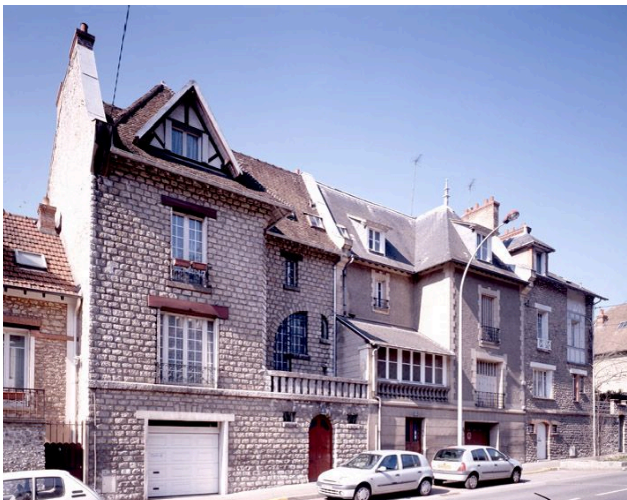
Vue d'ensemble, depuis la rue.
