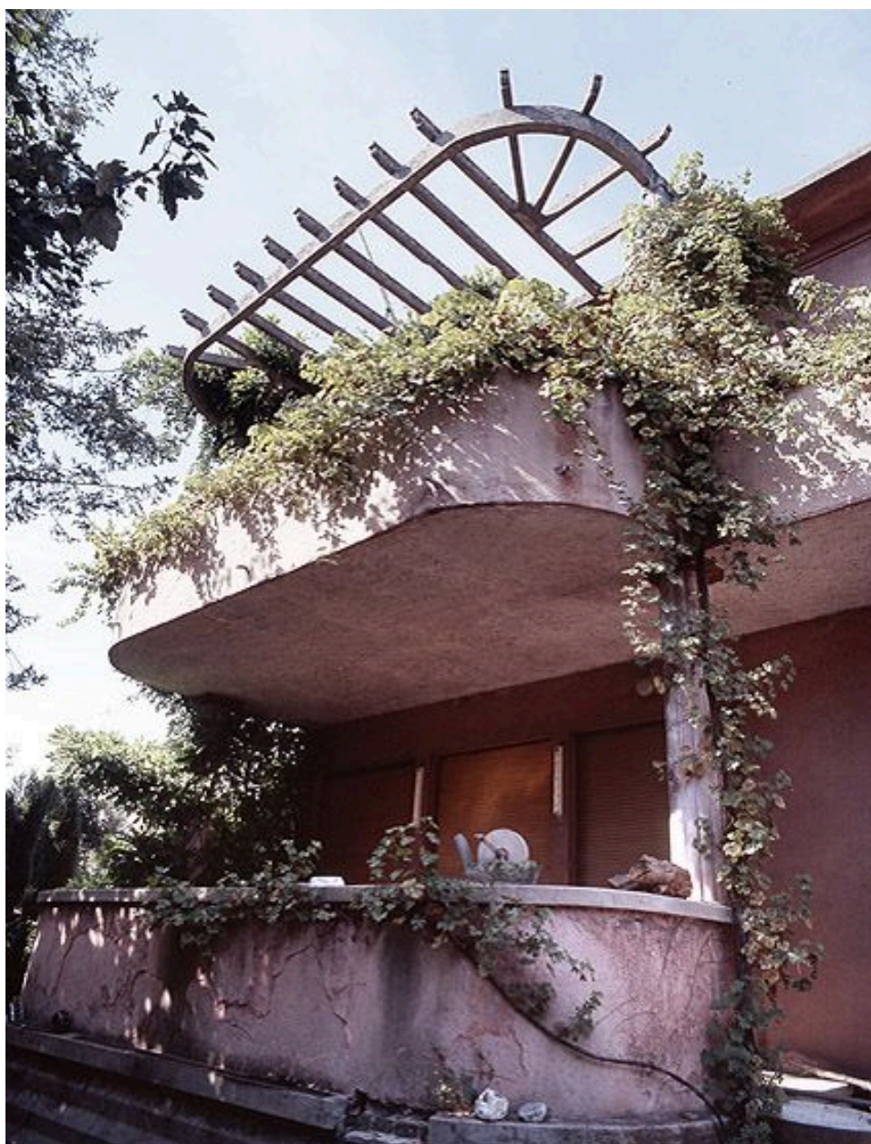
Détail des balcons et de la pergola d'une maison, 47 rue de la gaîté.
