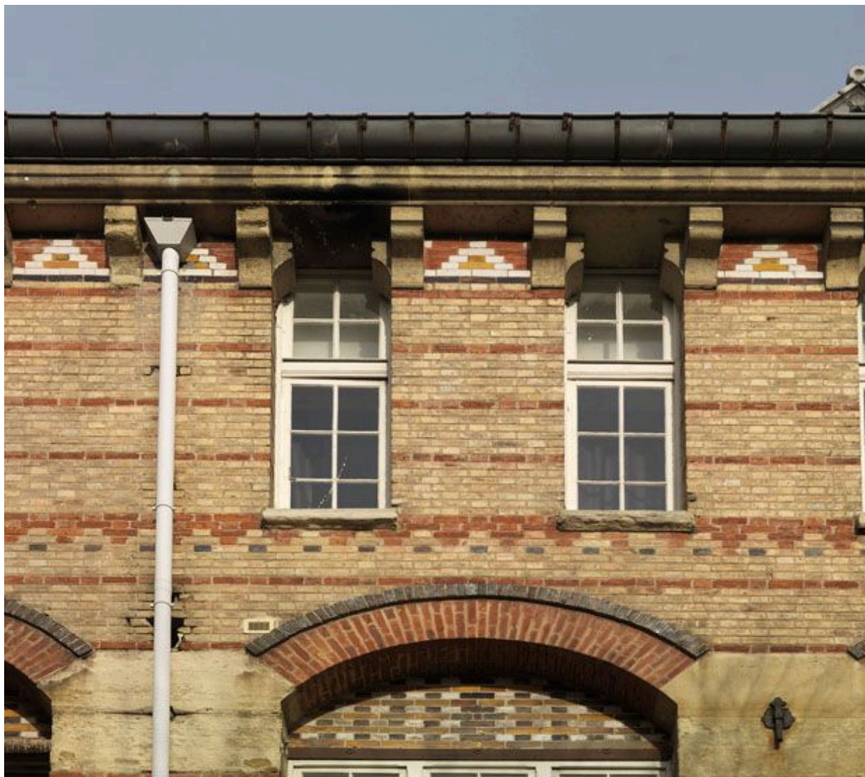
92, Sceaux, lycée Lakanal, 3-7 avenue du Président-Franklin-Roosevelt. Cour des grands : façade orientée au sud de l'aile séparant cette cour de celle des moyens : baies des fenêtres de l'étage supérieur.
