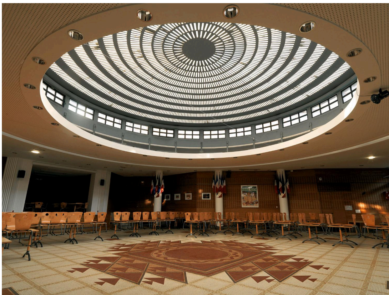
Vue générale de la coupole en pavés de verre surmontant la salle des fêtes-réfectoire.
