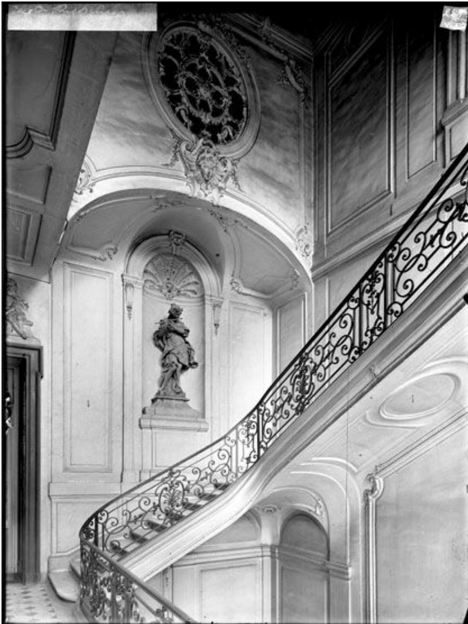
Vue d'ensemble de la seconde volée. photographie. (Commission du Vieux Paris, photographies Devismes)
