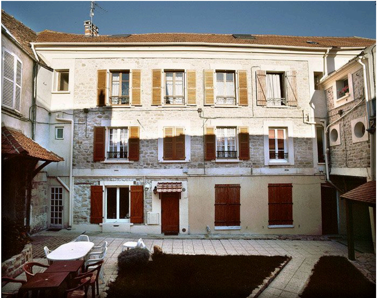
La façade orientale sur cour.
