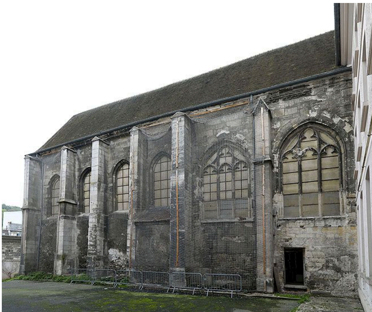
Vue extérieure : élévation sud, vue du sud-est.
