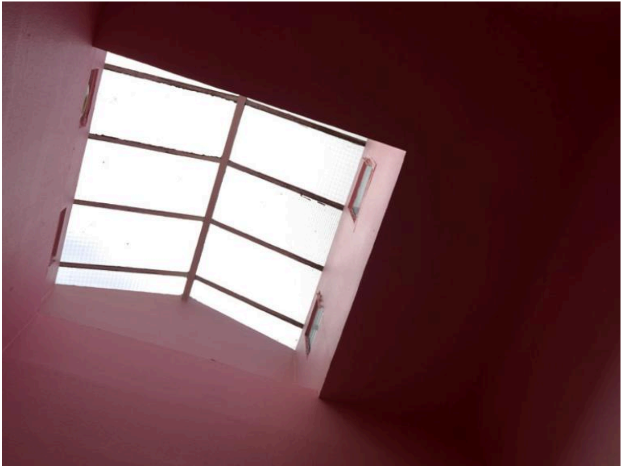
Le lanterneau de l'ancienne cabine de projection.
