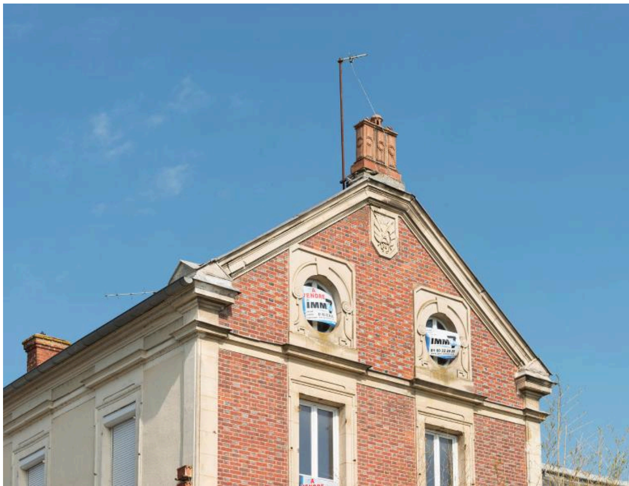
Immeuble 2 rue des Pelletiers : détail du mur pignon, inscription date "1872".
