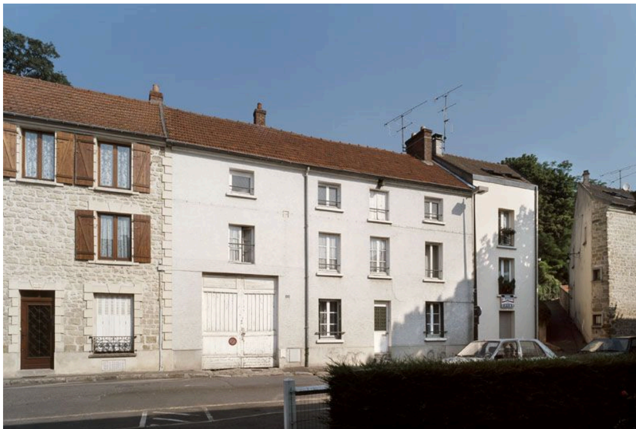
Andrésey. Maison de bourg dont les façades ont été transformées, 96-102 rue du Général-Leclerc.
