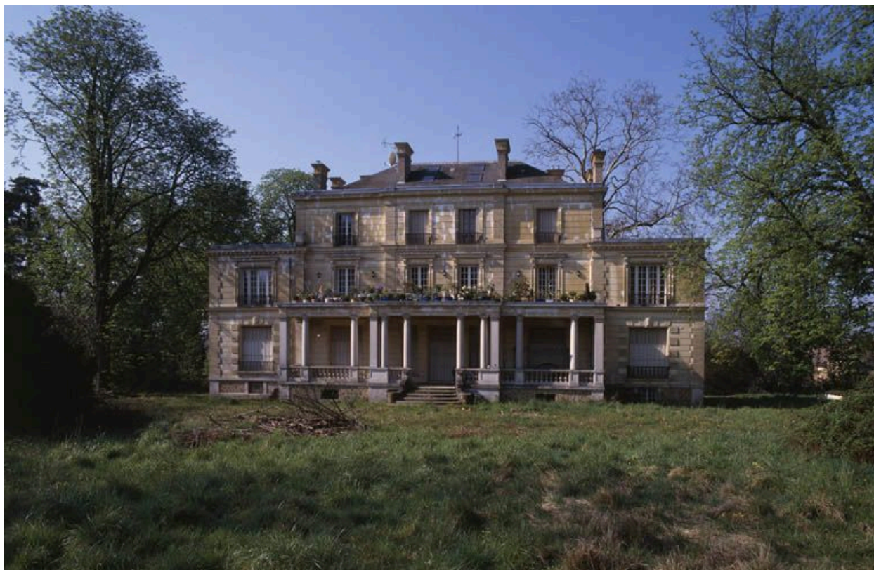
Vue de la façade arrière.
