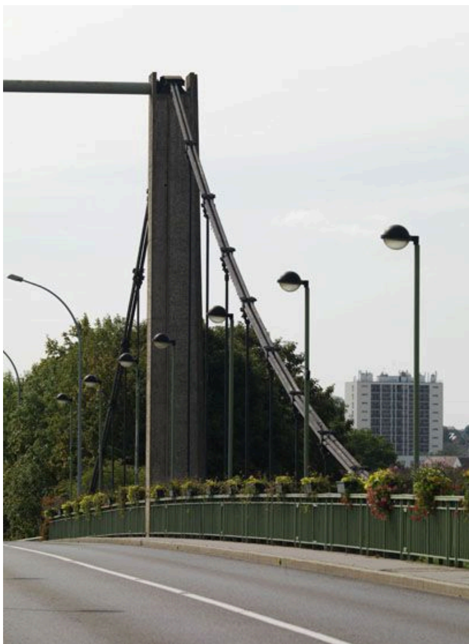
Tige de suspension soutenant les câbles et garde-corps vus depuis le pont vers l'aval.
