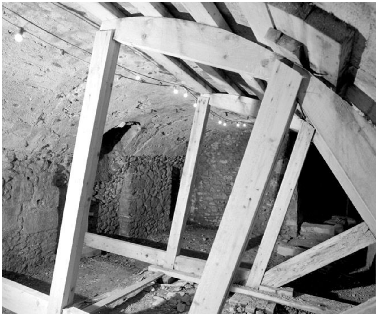
Vue du cellier à l'angle sud-est du prieuré, avec étais de confortement.
