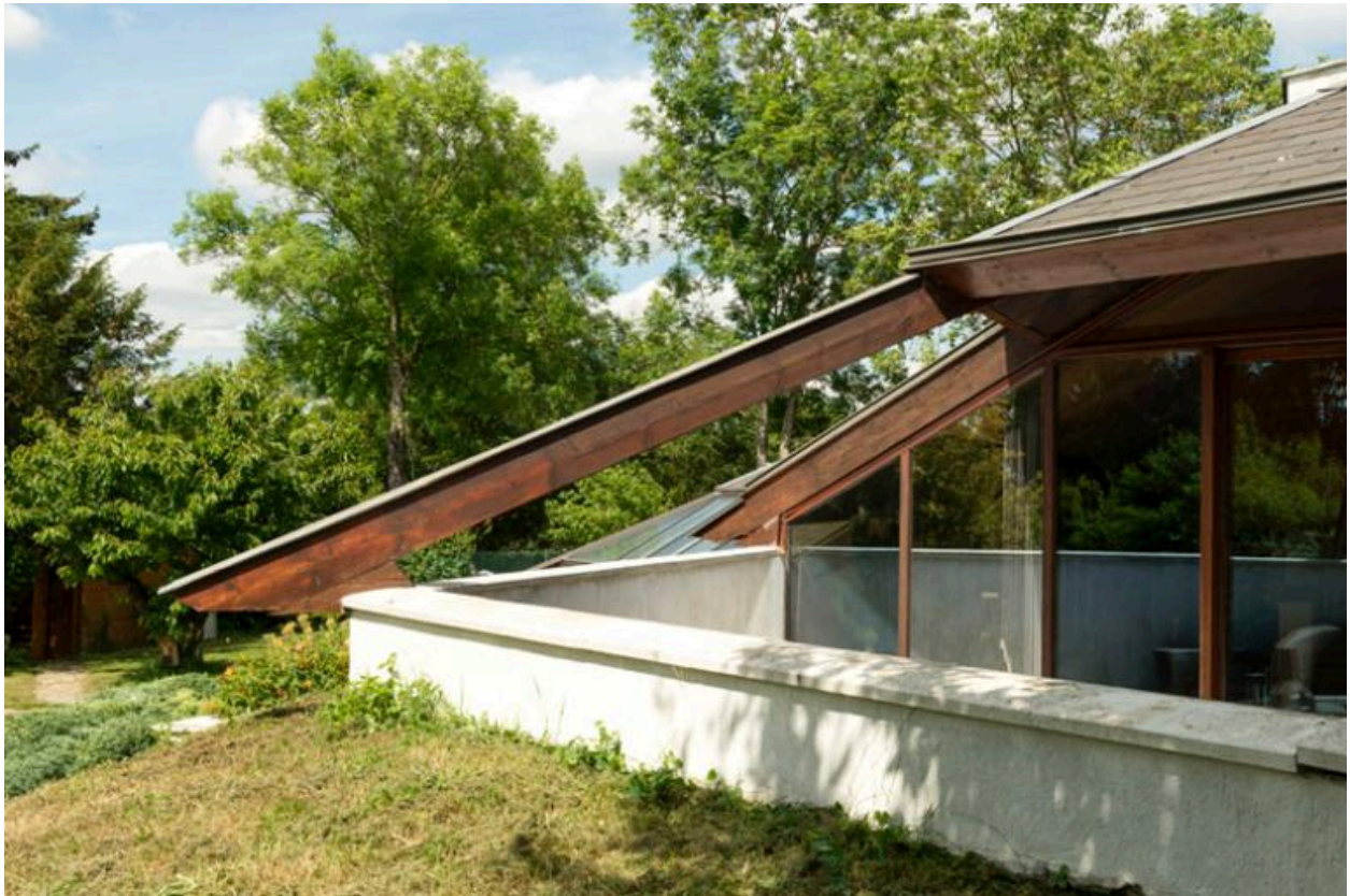
Détail de la toiture (côté droit).
