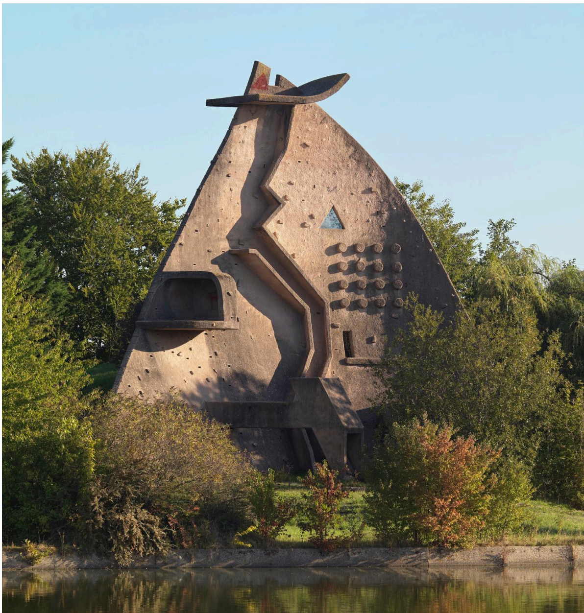
Vue générale de la Dame du Lac (paroi sud).
