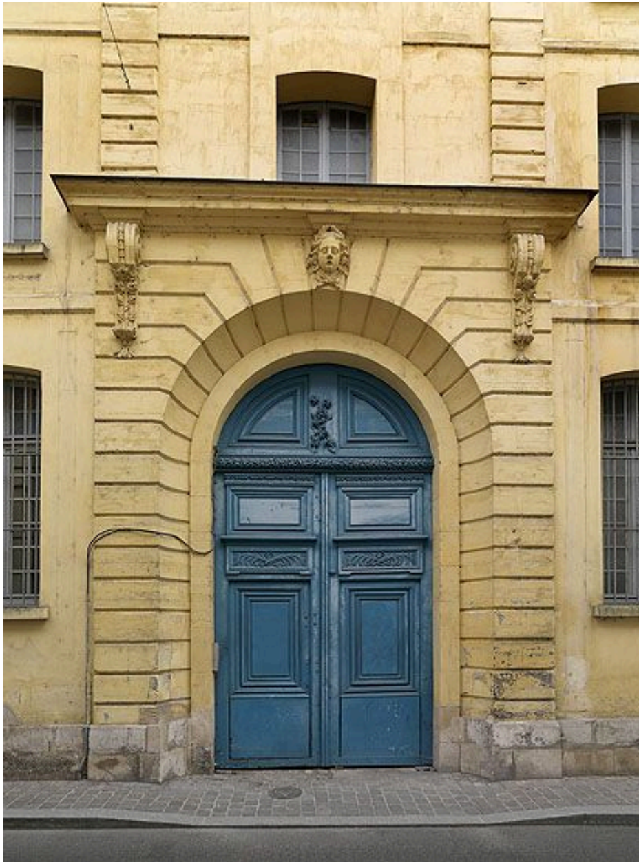
La façade de la rue Saint-Remy : le portail central.
