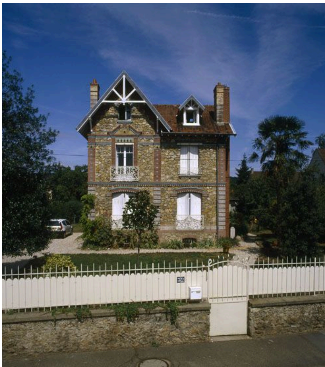
Vue d'ensemble de la façade sur rue.
