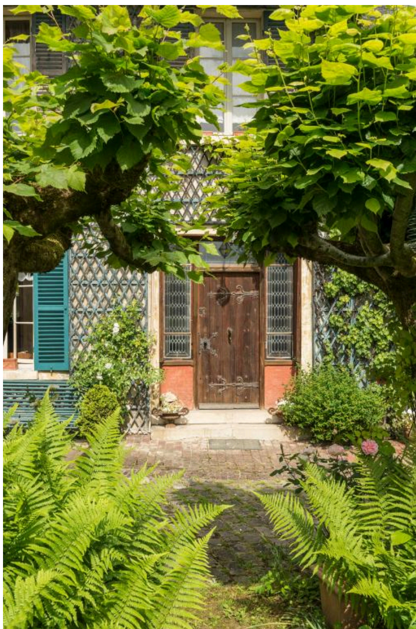
Détail de la porte d'entrée installée par Félix Martin-Sabon (1)
