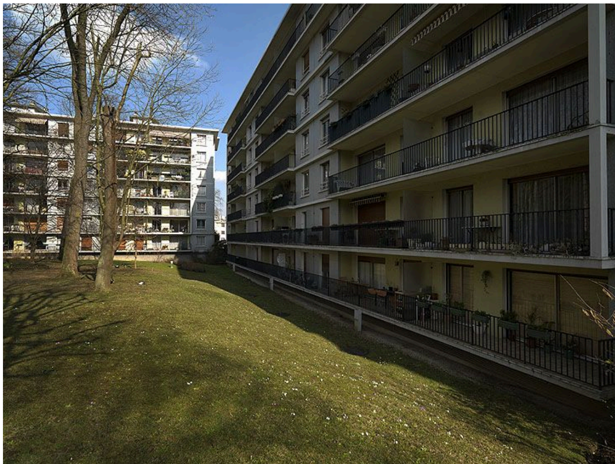
Thiais, cité dite parc de Thiais, 52-64 rue Victor-Basch. Ensemble construit en 1962 par A. Fur et E. Mercier, architectes.
