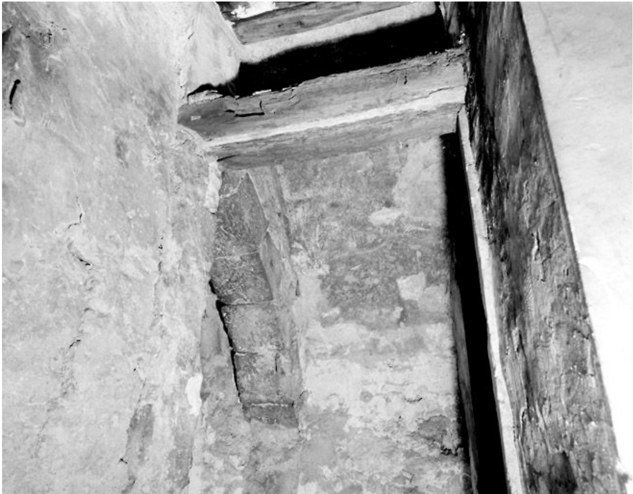
La cave nord : détail de la partie ouest (cave médiévale), l'arc occidental vu depuis l'allée centrale.
