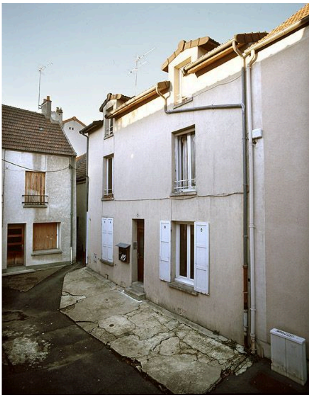
Vue de l'extrémité nord de la façade occidentale de la cour.
