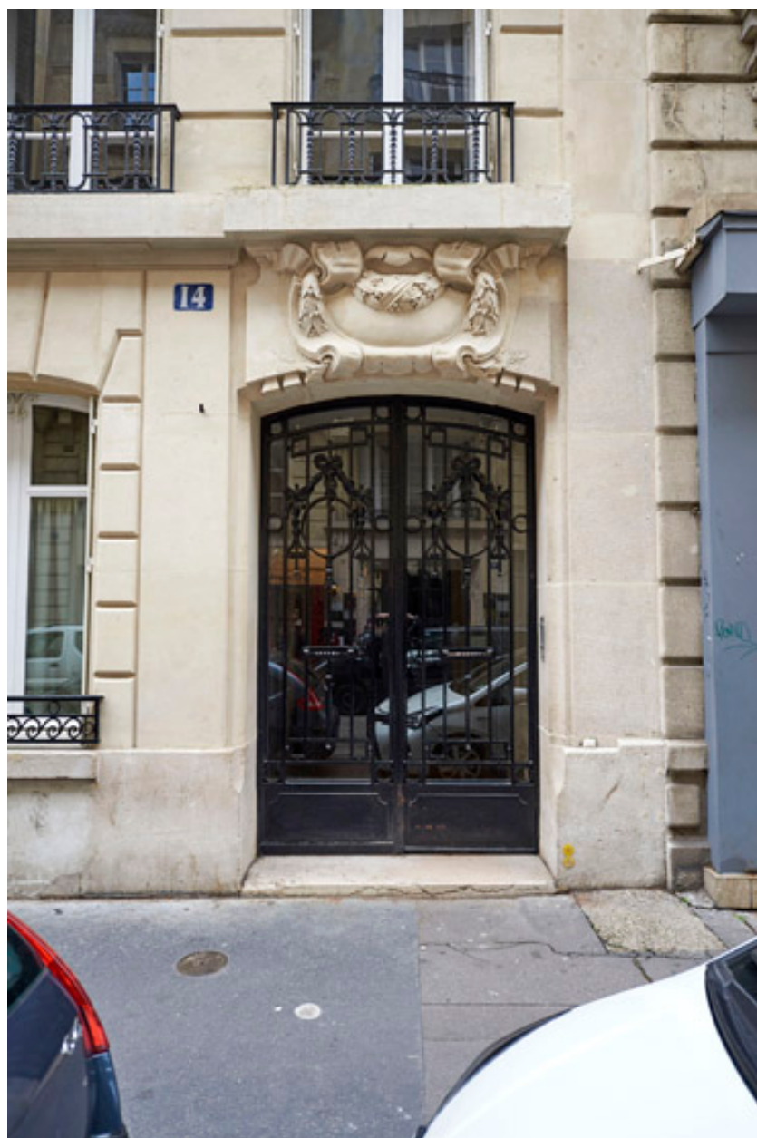
Vue de la porte batarde.
