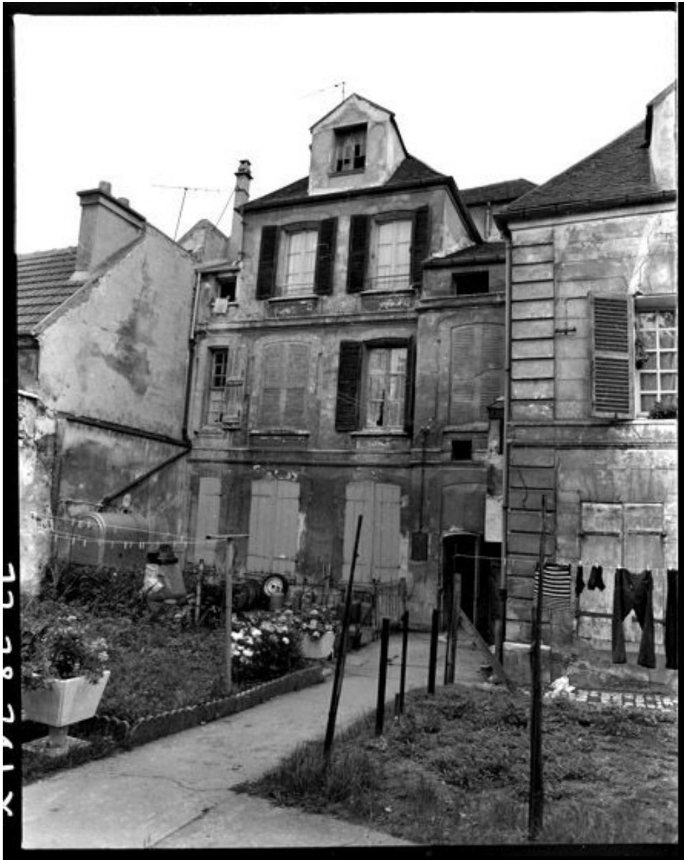
Maison, Sangle (rue de la) 36. La façade arrière du bâtiment principal.
